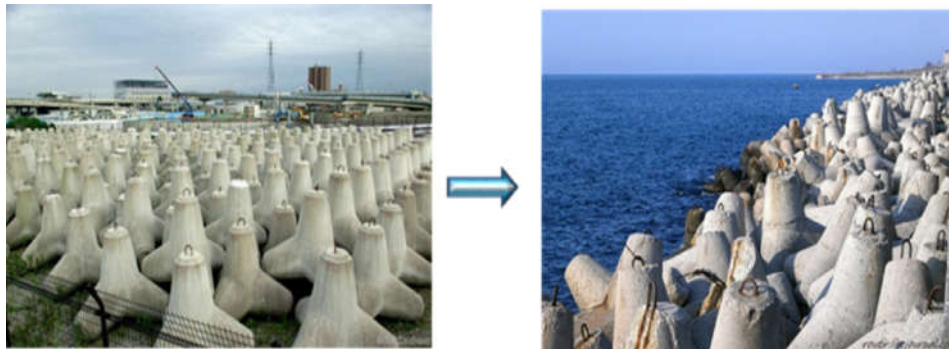
Hình 1. Hình ảnh nhím biển của đê chắn sóng
